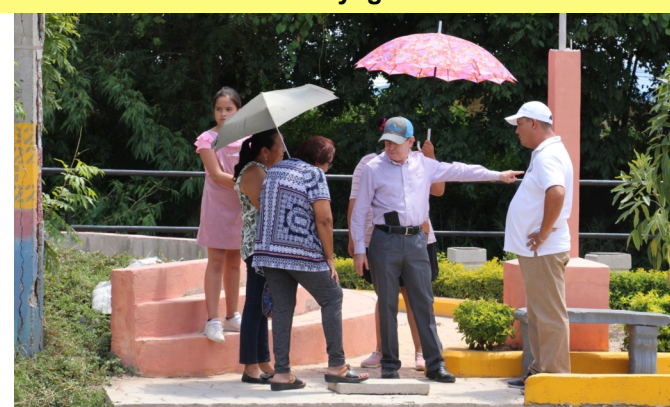
Esta obra es construida con fondos de la Alcaldía más una contraparte de la comunidad.
